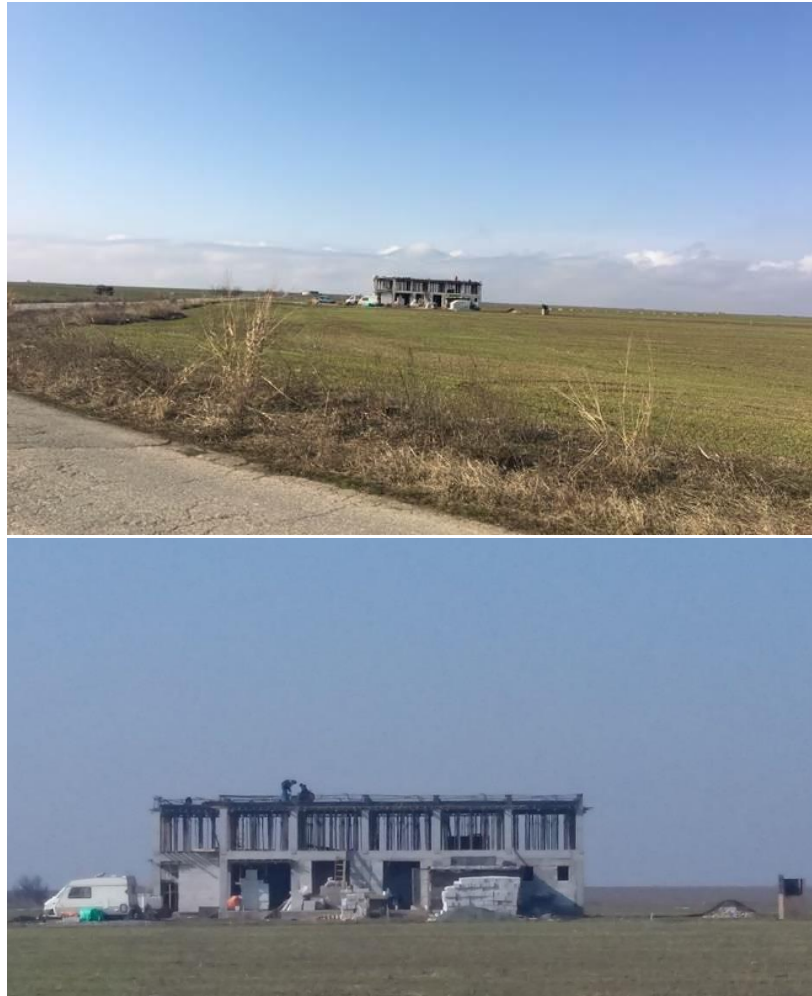
Figura 9-7 Pensiune în construcție în Vadu (Februarie 2019)
